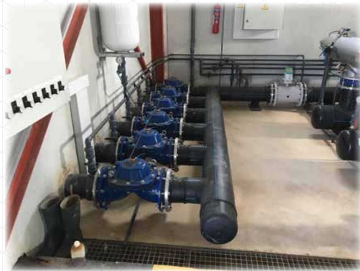
COLECTOR DE SALIDA EN POLIETILENO CON 6 VÁLVULAS HR10 8" BRIDA PN10
